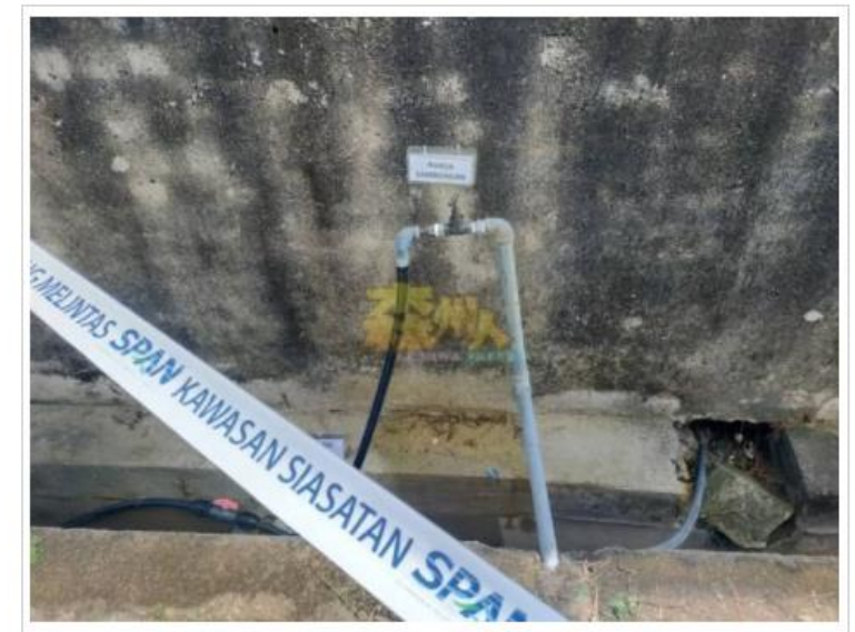
执法人员在工厂内发现非法接驳水源的水管。
